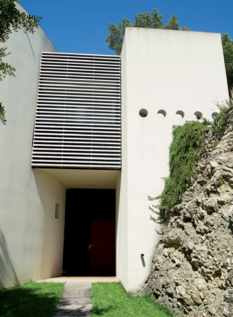
Au niveau du rez-de-jardin bas, un cheminement fait d'anciennes traverses de chemin de fer conduit jusqu'au seuil, surmonté par une tour de guet contemporaine.
