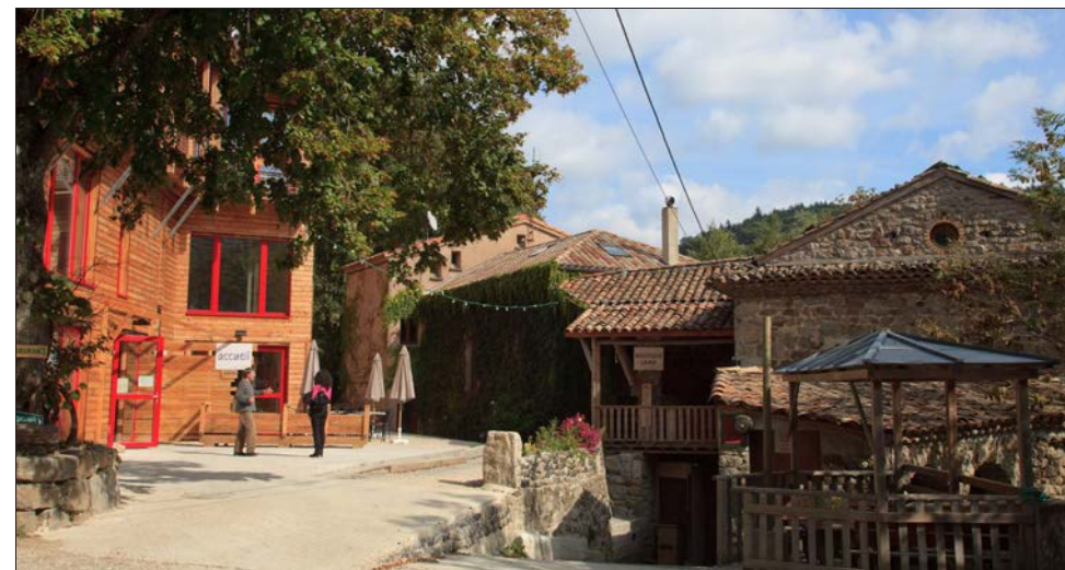
Un bâtiment HQE flambant neuf face une filature du XVIII e siècle, c'est le nouveau visage du siège social d'Ardelaïne. Photos Philippe FOURNIER
