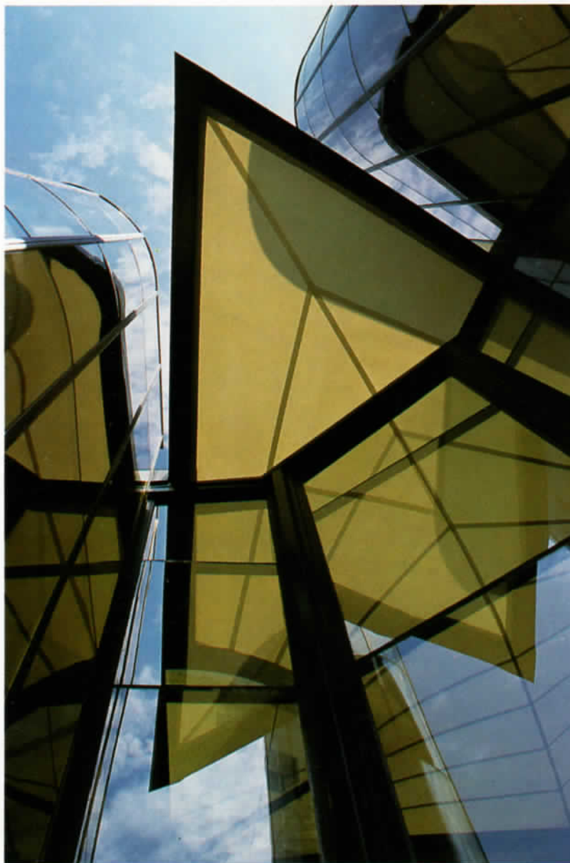
Géométrie de verre et de toile tendue dans la partie haute de l'Institut des polymères.
