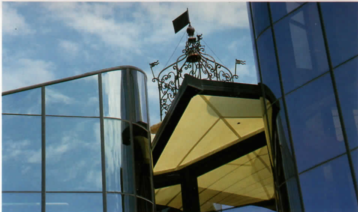
Comme posée par dessus les murs- miroirs de la maison Milon la campanile et ses courbes de fer forgé.
